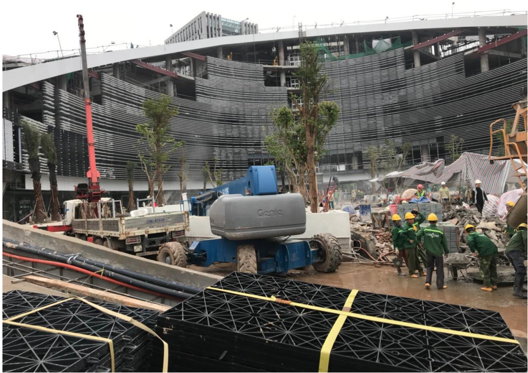
Hình 3. Dự án Đầu tư Xây dựng Trụ sở Tòa nhà Viettel
