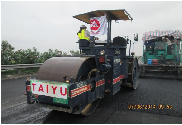
Thử nghiệm bê tông nhựa rỗng có sử dụng phụ gia TPS (TafPack-Super) Testing of hollow concrete with additives TPS(TafPack – Super)
