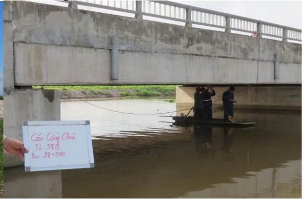
Thí nghiệm, kiểm định thử tải cầu Công Chéo tỉnh Thái Bình Construction quality control, loading test of Cong Cheo Bridge, Thai Binh Province
