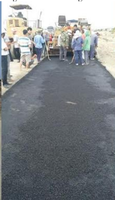
Nghiên cứu thử nghiệm vật liệu Carbonco Asphalt trên dự án QL1 tỉnh Ninh Thuận Research Testing of Carbonco Asphalt material at National Highway 1 Project, Ninh Thuan Project
