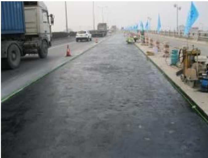
Thử nghiệm bê tông nhựa rỗng có sử dụng phụ gia TPS (TafPack-Super) Testing of hollow concrete with additives TPS(TafPack – Super)
