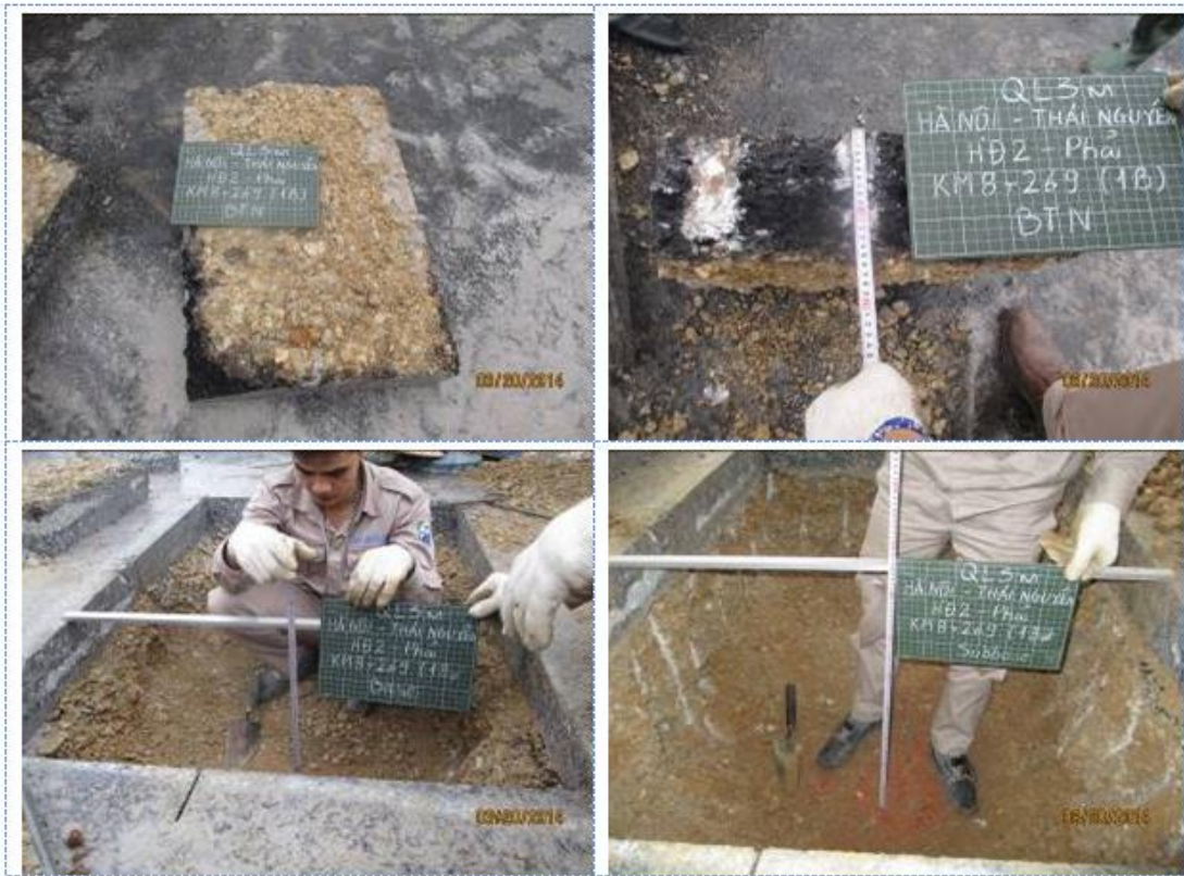
Thí nghiệm, kiểm định CLTC Dự án QL3 mới Hà Nội – Thái Nguyên Testing to review the construction quality National Highway No.3 Project, Ha Noi – Thai Nguyen
