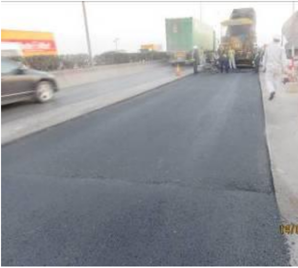
Thử nghiệm vật liệu nhựa đường cao su hóa Rubber Asphalt – RA Testing of Rubber Asphalt Material
