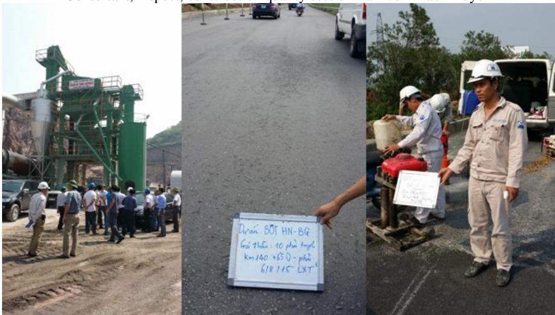
Thí nghiệm, kiểm định dự án BOT Hà Nội – Bắc Giang Consultant, inspect, construction quality BOT Ha Noi – Bac Giang Project
