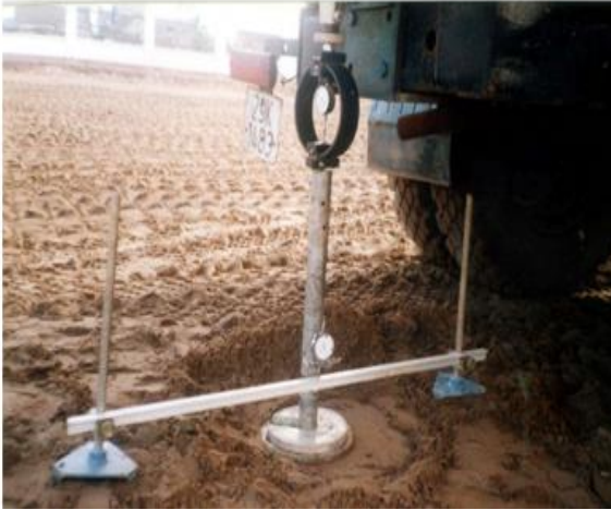
Hình 54. Thí nghiệm CBR tại hiện trường Figure 54. California Bearing Ratio at site
